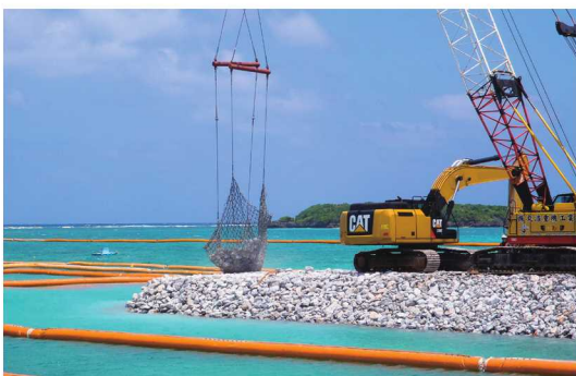
護岸の施工状況①
