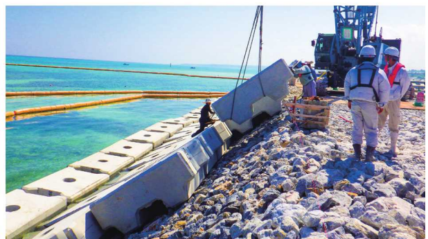
護岸の施工状況②
