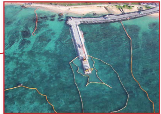
辺野古側中仕切護岸の施工状況（12月現在）
