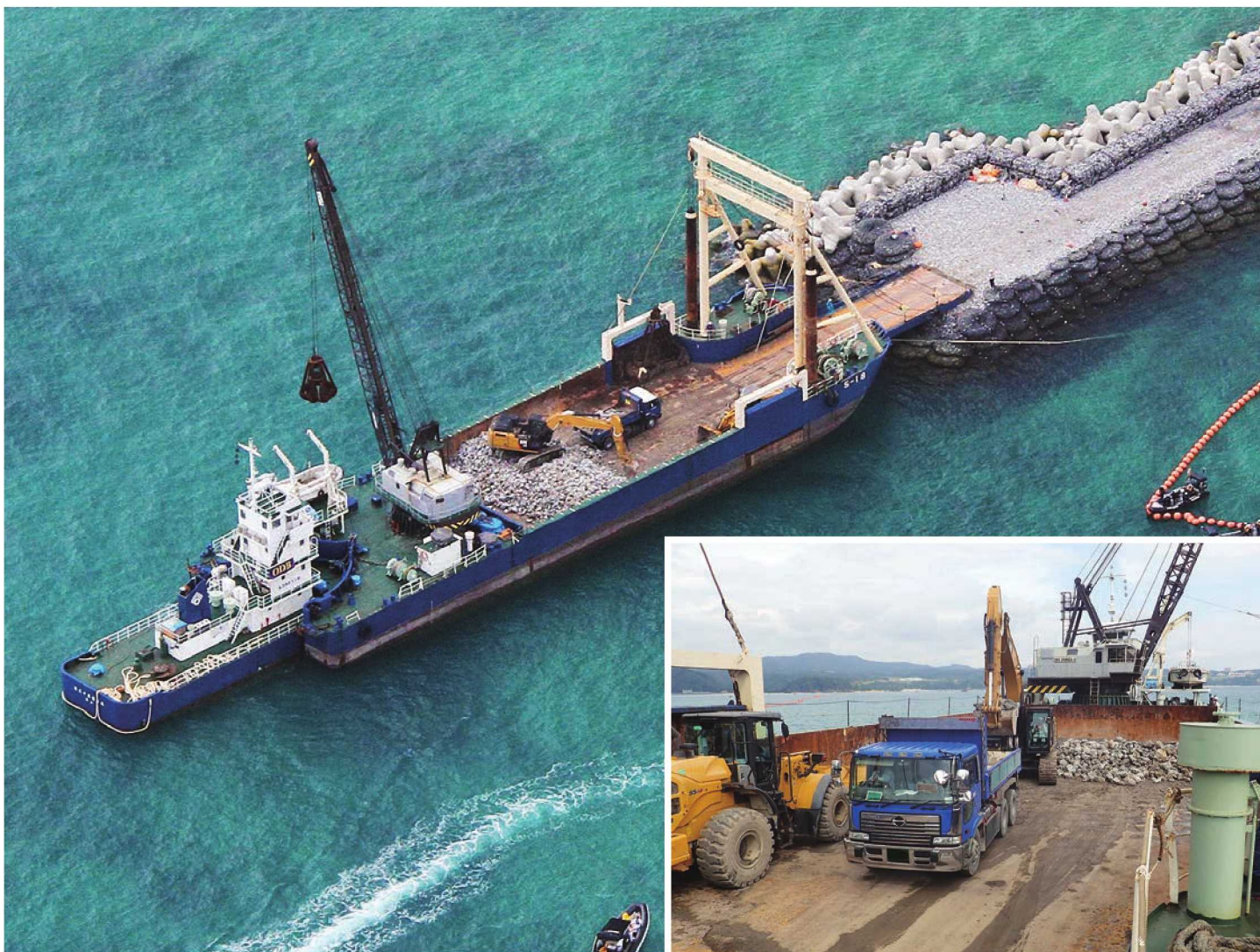
海上からの石材搬入の様子
