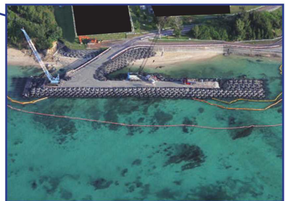
辺野古側仮設道路の施工状況（12月現在）
