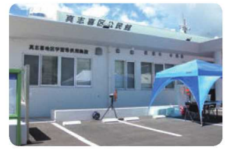
真志喜地区学習等供用施設の外観
