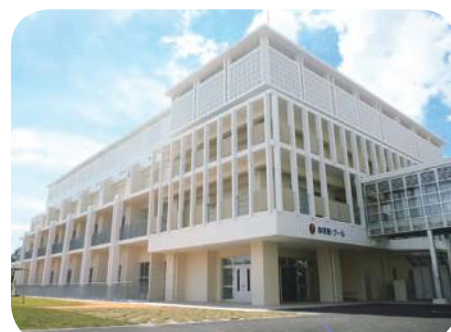
完成した嘉手納小学校講堂の外観
