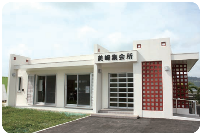
完成した美崎集会所の外観
