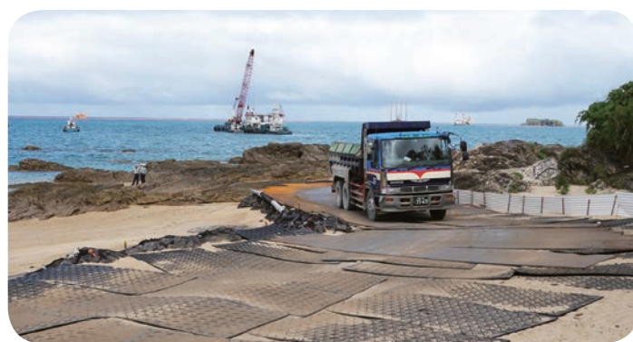
護岸への砕石の搬入状況
