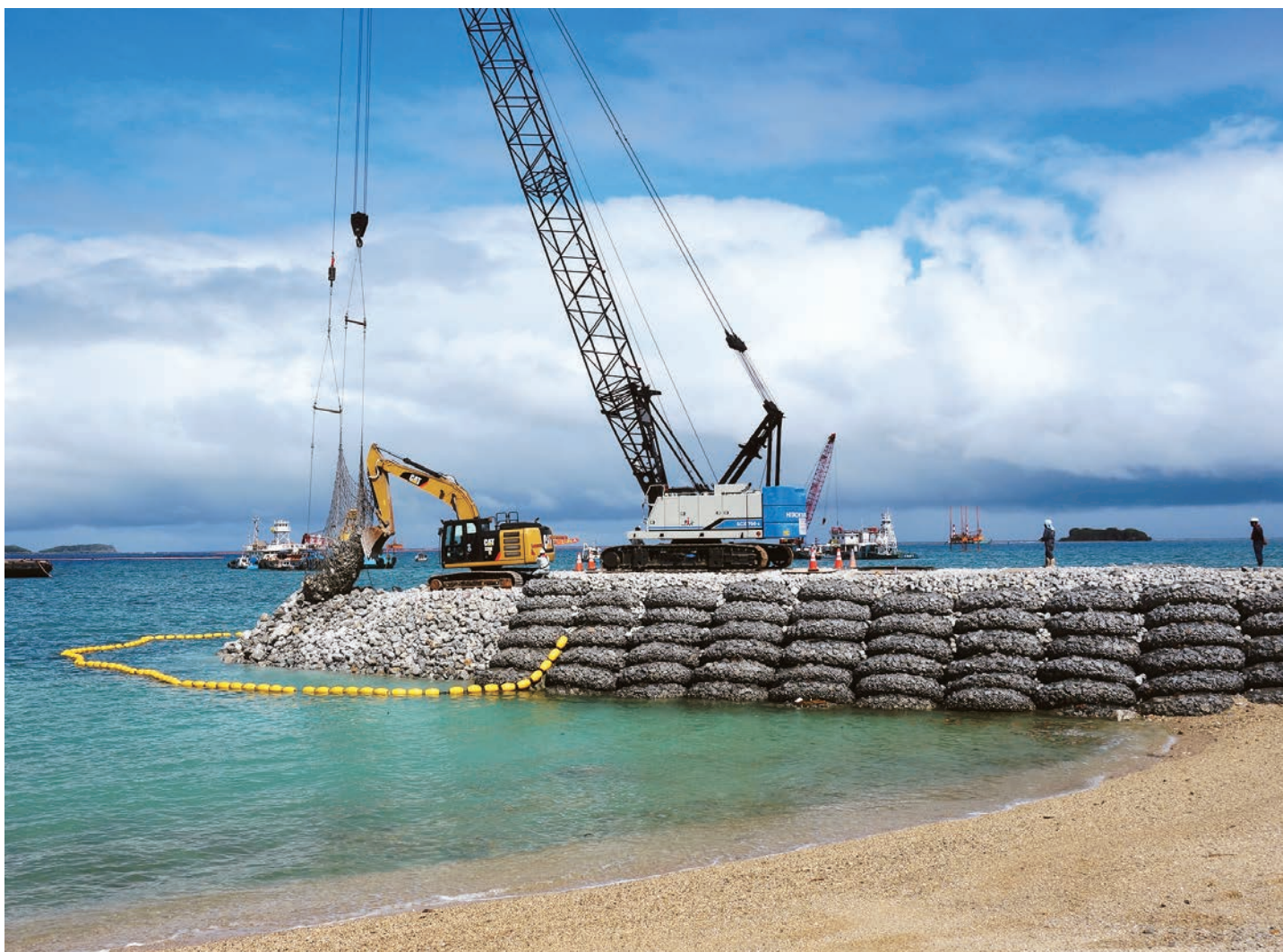
護岸工事の様子
