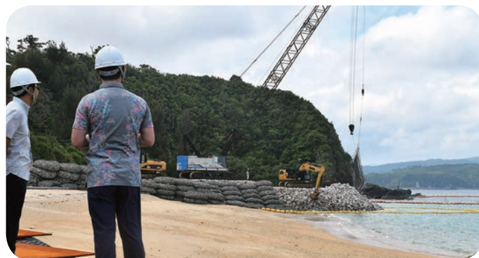
護岸工事を視察している様子
