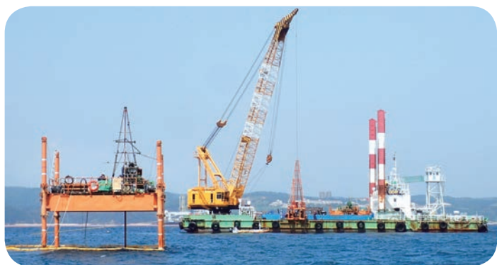
ボーリング調査の実施状況
