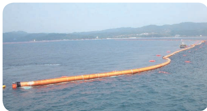
汚濁防止膜の展張状況
