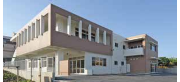
完成したコミュニティ供用施設及び児童館の外観
