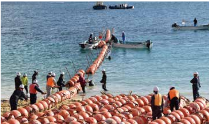
フロートの再設置
