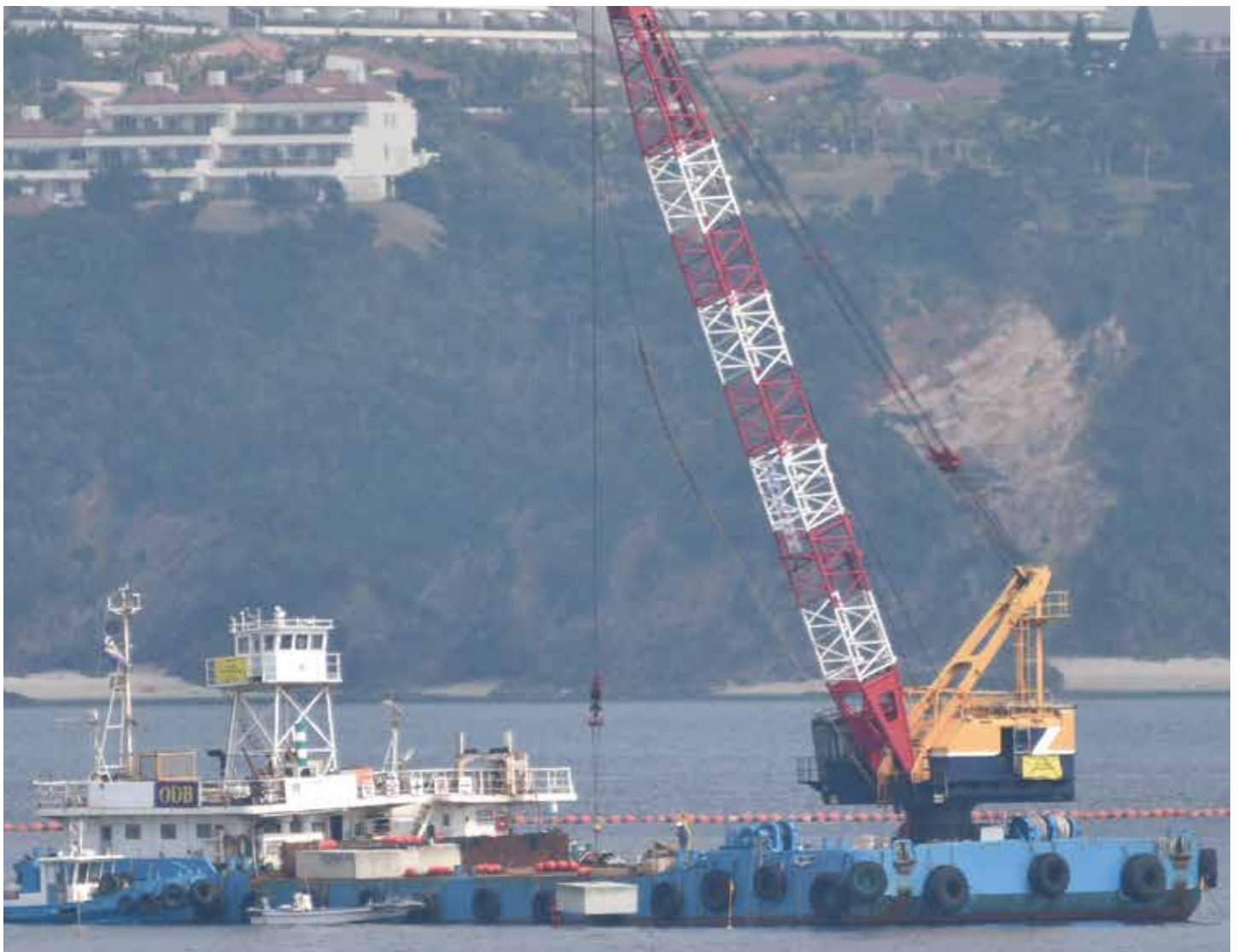
汚濁防止膜用コンクリートブロックを設置する様子
