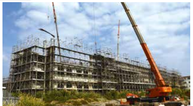
隊舎で残っていた型枠等を撤去
