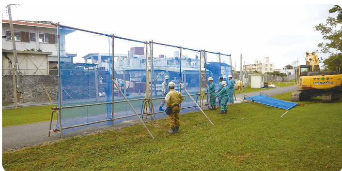
普天間飛行場の東側沿い返還予定地内の巡回道路等の移設工事
