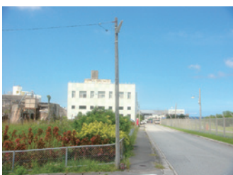
北谷町（街灯敷地）
