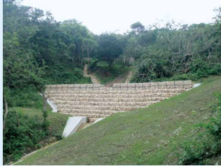
周辺洪水対策：谷止工（南城市）
