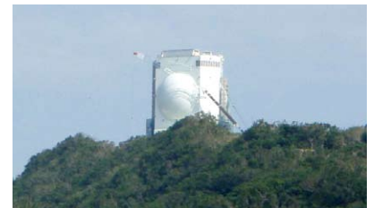
工事中のFPS-5レーダー
