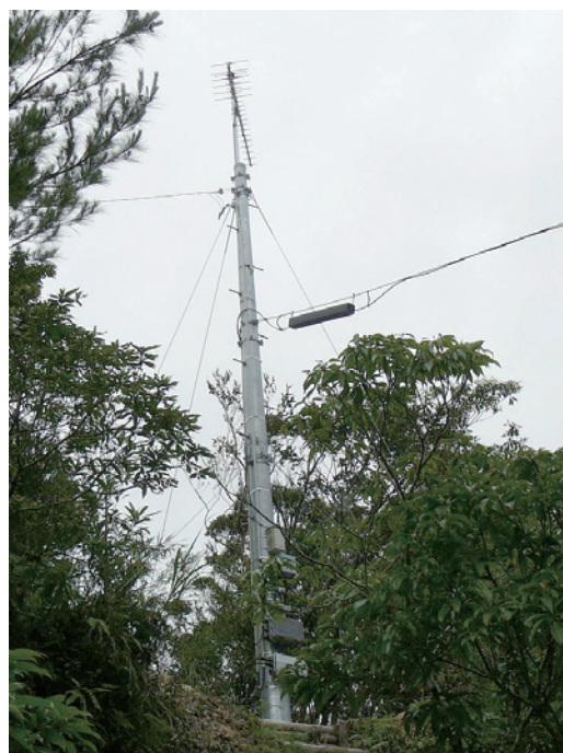
新設した受信所
