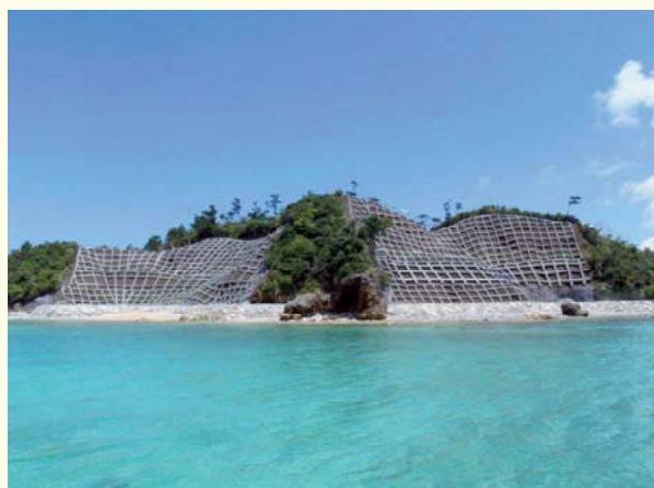
奥間防災工事
