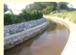
新川改修工(恩納村)
