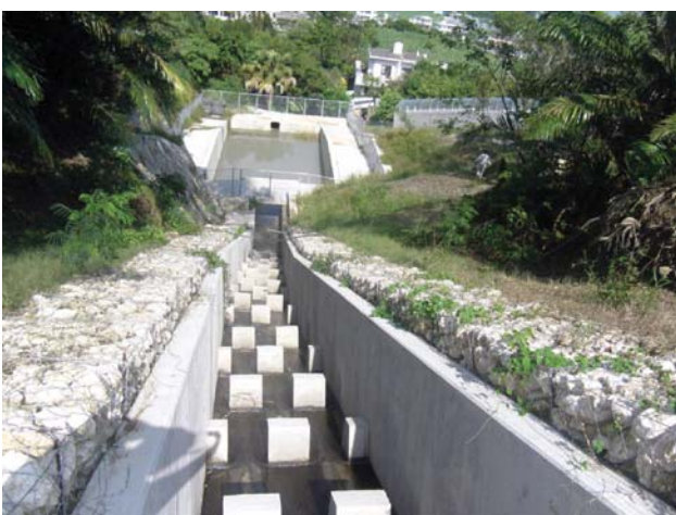
(雨水を安全に流下させる沈砂池・排水路工)
