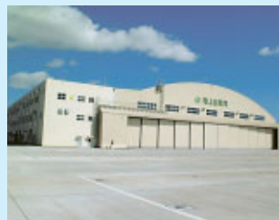
【自衛隊施設整備】 陸自・那覇基地内 —航空機整備場—
