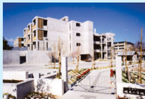
「騒音障害を防ぐ」学校の防音工事（那覇市）
