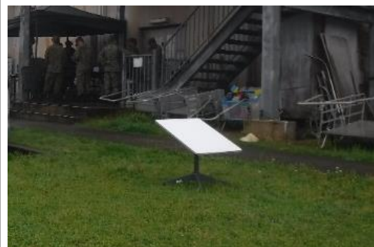
衛星通信アンテナの設置
