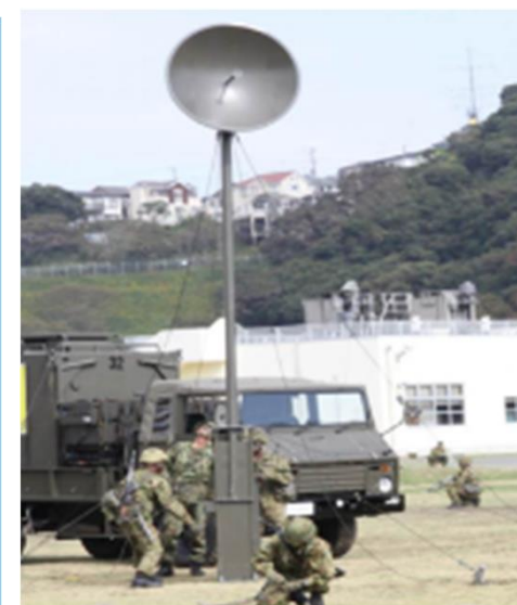
無線搬送端局（中継）装置3号
