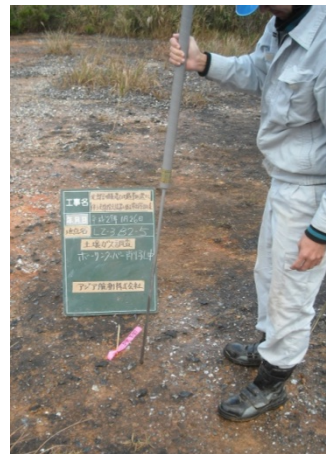
ボーリングバーによる掘削
