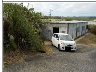
No.10 山城進入路沿い黙認耕作地内のプレハブ小屋
