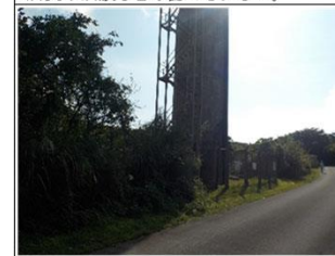
No.19 山城進入路沿いにある県企業局の水タンク
