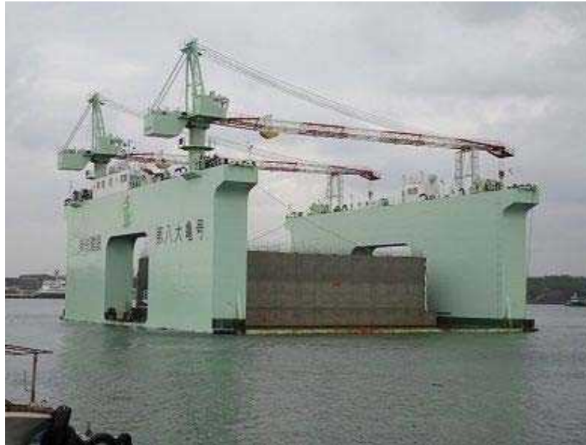
写 2.2-1 ケーソン製作工(RC ケーソンの例)
