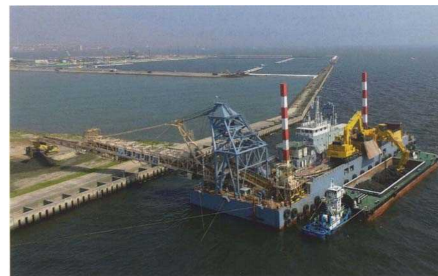
写 2.4-1 リクレーマ船による揚土状況の例
