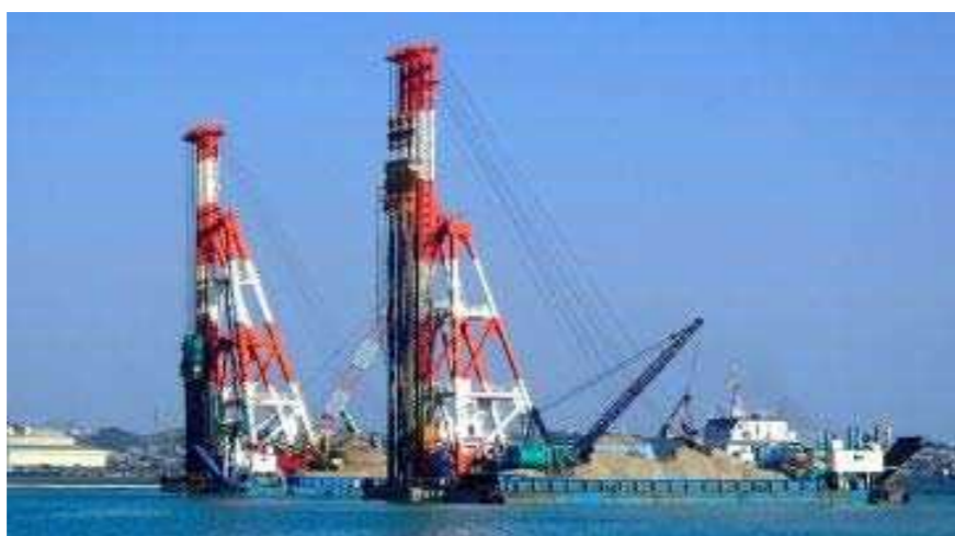
写 2.1-2 SD工法の施工状況の例
