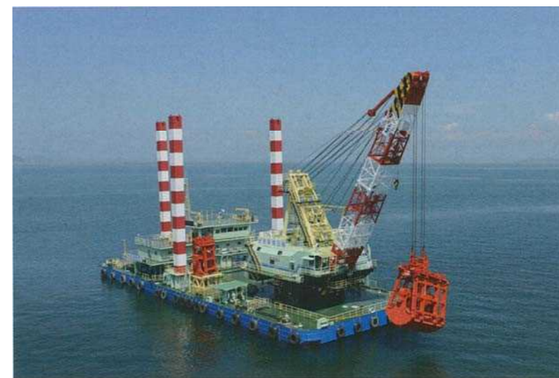
写 2.2-5 グラブ浚渫船
