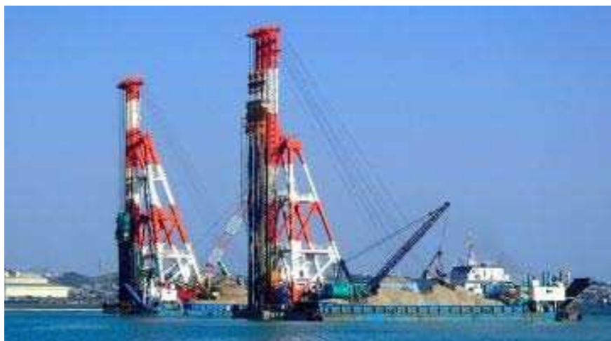
写 2.1-1 SCP工法施工状況の例
