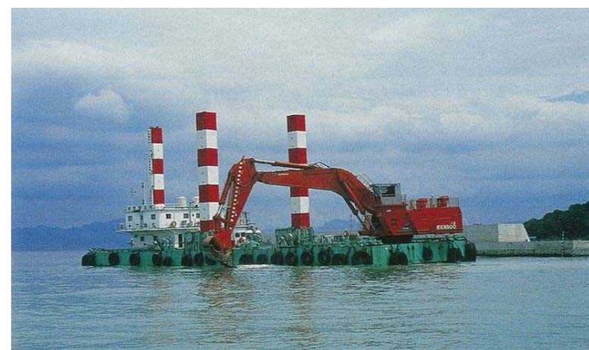
写 2.1-4 バックホウ浚渫の施工状況の例
