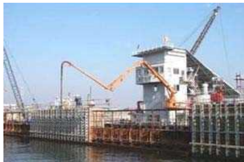
写 2.3-2 上部工施工状況の例
