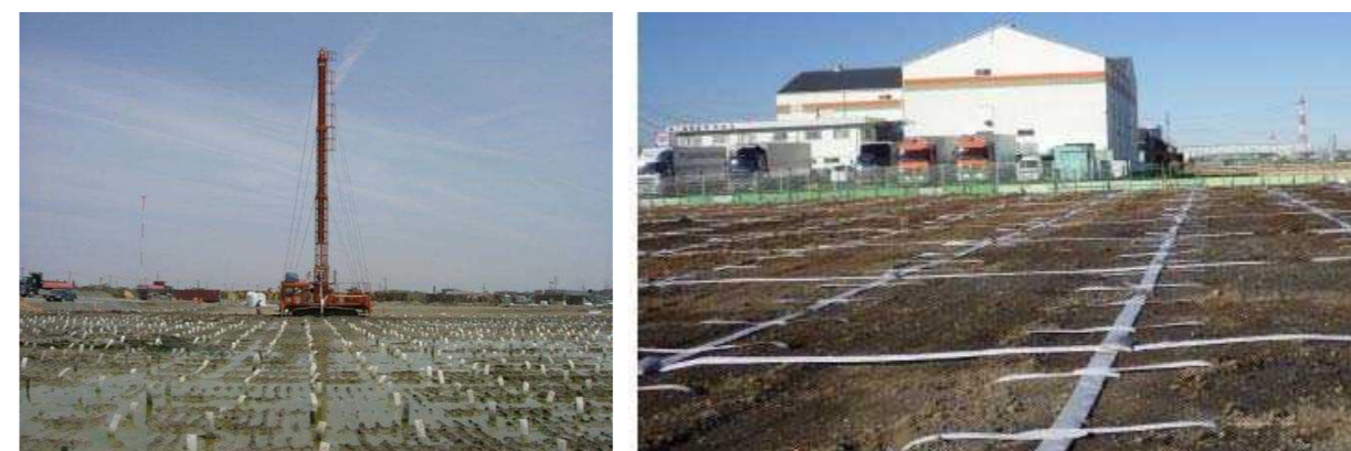
写 2.1-3 PD工法の施工状況の例(左:鉛直材打設状況、右:水平材敷設状況)
