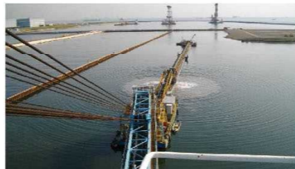
H21南本牧埋立事業(中継所土砂揚土)
