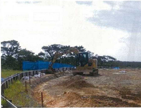
赤土対策工(素堀側溝)。左:築造状況、右:設置後
