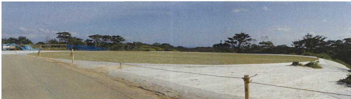
施工区域の完成状況:平成 25 年 2 月
