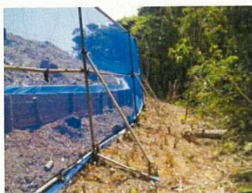
防風柵の設置
