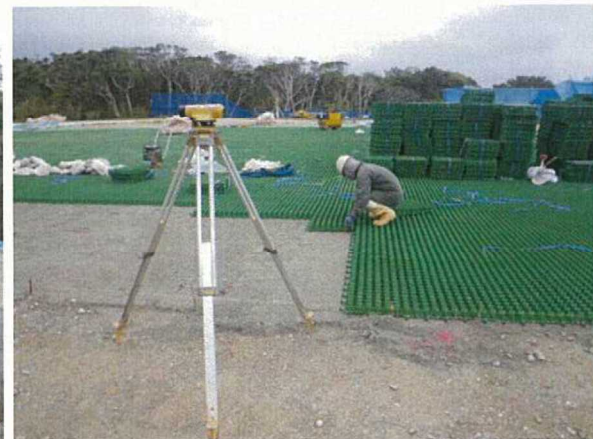
舗装工。左:転圧状況。右:表層の芝生保護材の敷設状況
