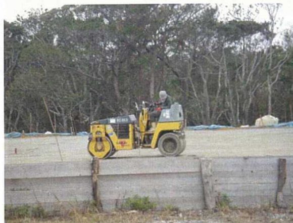
舗装工。左:転圧状況。右:表層の芝生保護材の敷設状況
