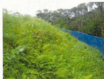
無障害物帯の状況 (平成 23 年 10 月)
