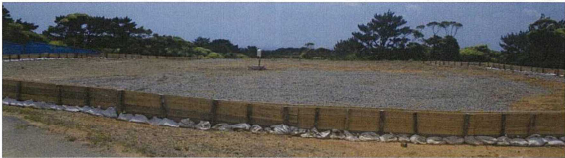
施工区域の状況:平成 23 年 4 月
