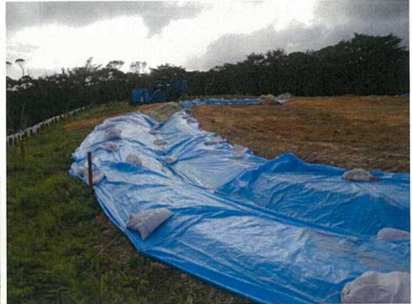
赤土対策工(素堀側溝)。左:築造状況、右:設置後
