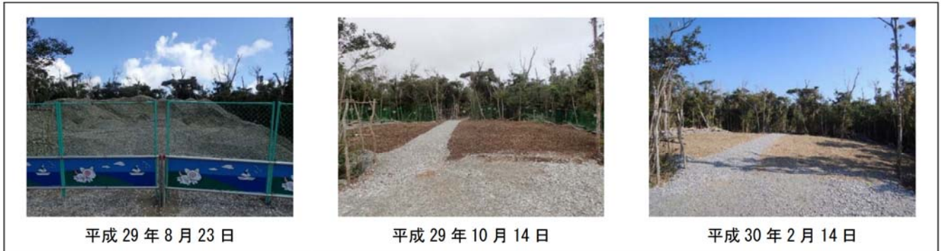
図 6.2.3-82 工事による副次的影響の復元箇所の状況(G 直近の作業ヤード)
