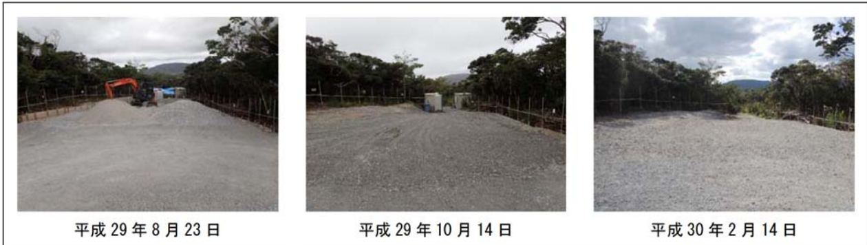
図 6. 2. 3-80 工事による副次的影響の復元箇所の状況(既存道路北側作業ヤード)
