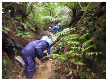
土砂の除去状況
