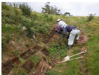
復旧作業の状況
