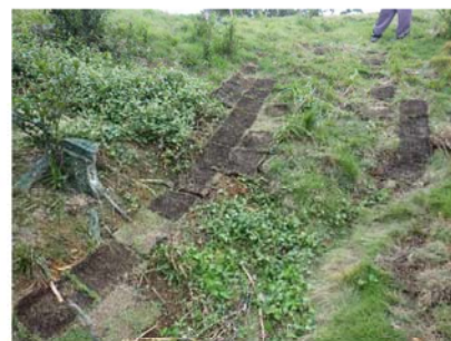
復旧後の状況
