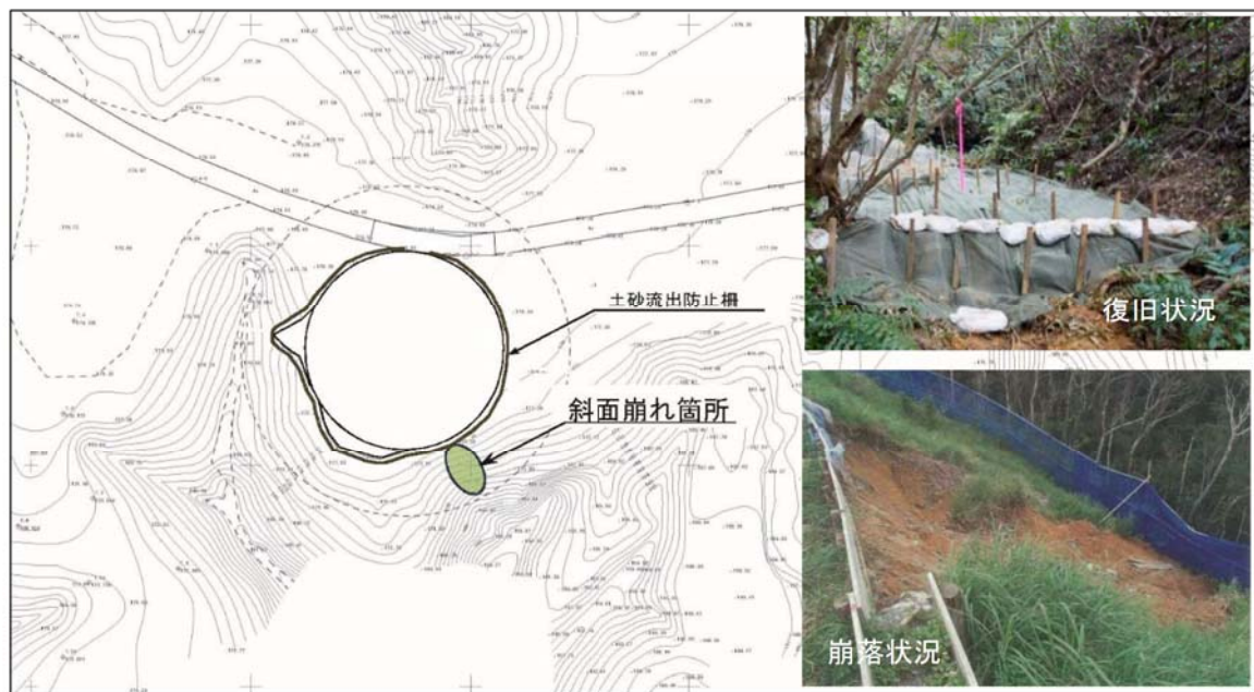
図 4.5-1 崩落地点及び崩落状況
