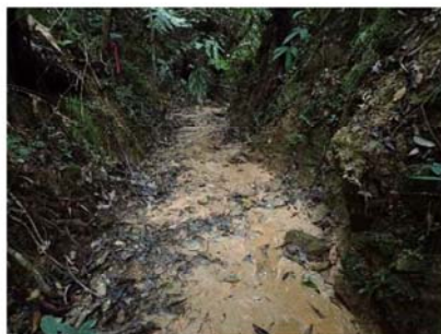
流出後の状況(平成 28 年 12 月)
