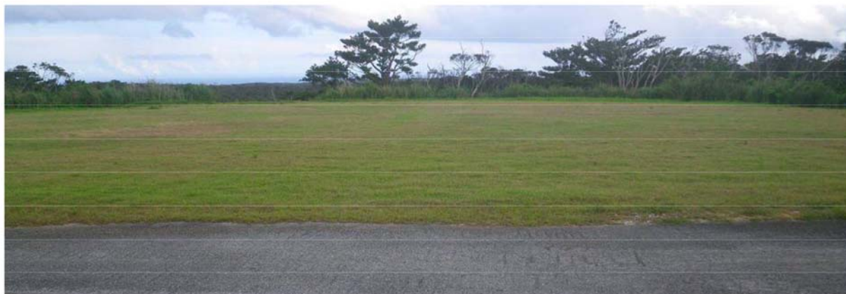
図 4.1-1 完成した N-4.1 着陸帯の状況:平成 27 年 6 月
