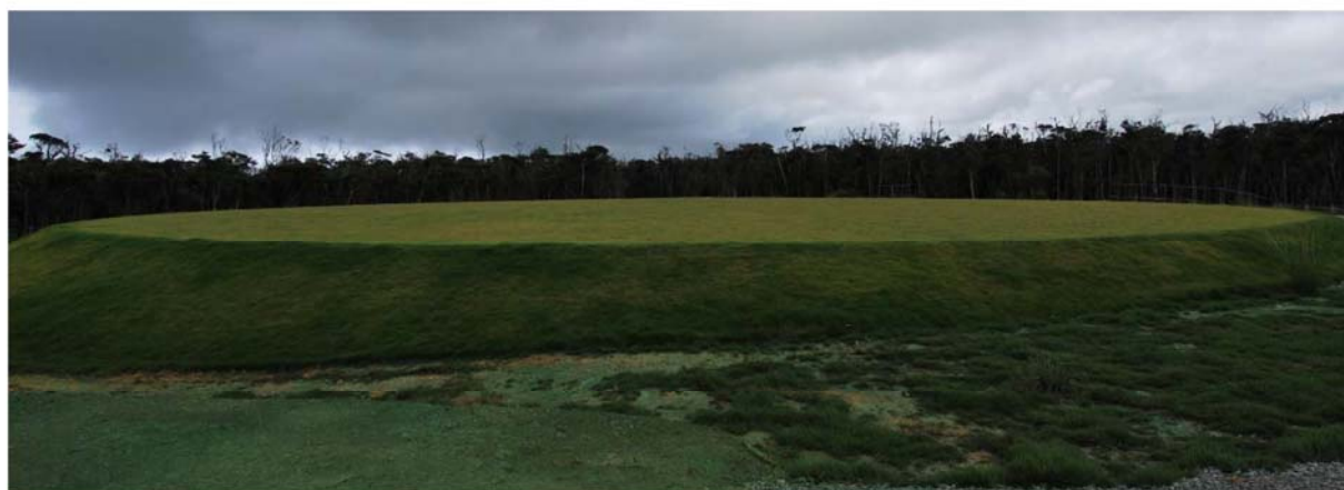
図 4.1-3 完成した G 着陸帯の状況:平成 29 年 10 月
