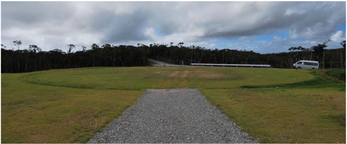
図 4.1-5 完成したN-1(a)着陸帯の状況：平成 29 年 10 月
