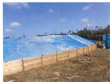
シート保護による赤土流出防止対策
