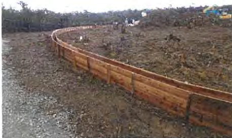
土砂流出防止柵の設置
