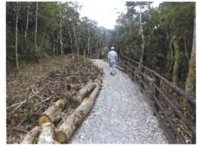
歩道脇への敷き均し
