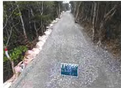
碎石敷きの仮設(歩道)
