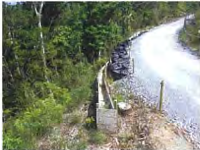
土砂流出防止柵の設置(既存道路の崩落箇所)
