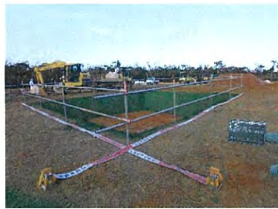
沈殿池の設置
