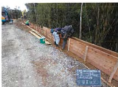
赤土流出防止柵の設置
