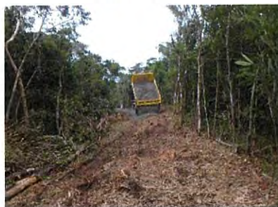
赤土流出防止柵の設置
