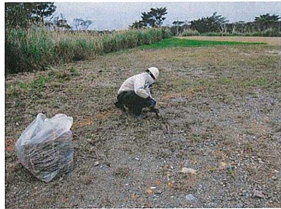
除去作業 平成27年2月26日撮影
