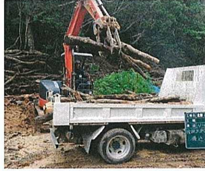
車両への伐採木の積み込み
