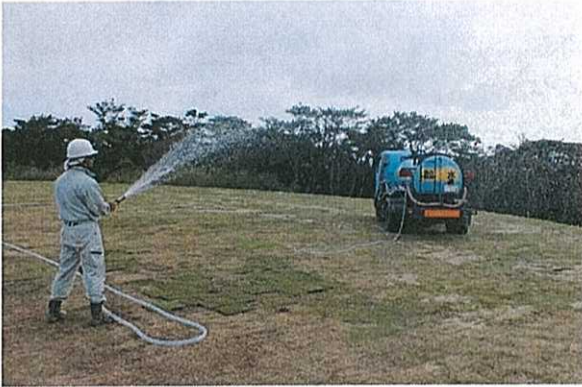
散水車(張芝への散水状況)
