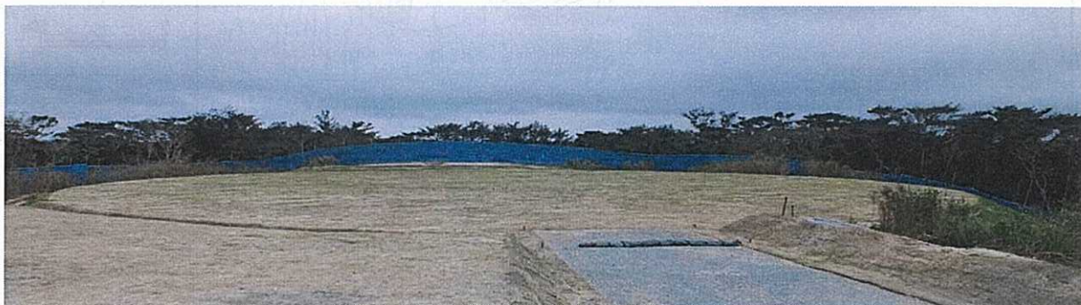
概ね完成したN-4.2着陸帯の状況:平成26年3月
