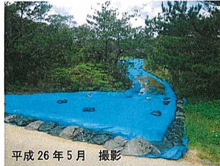
シート・土嚢設置状況 (N-4.1 北西側の土砂置場)
