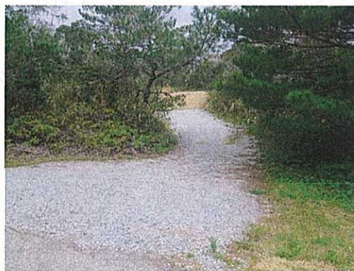
砕石敷き(N-4.1 北西側の土砂置場:進入路)
