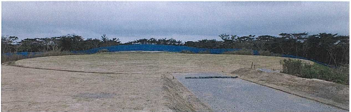
施工区域 (N-4. 2) の状況:平成 26 年 3 月
