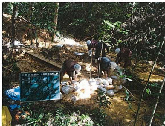
土砂崩れ下部への土嚢設置
