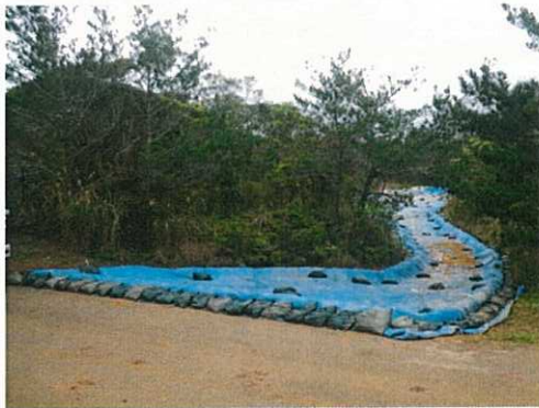
シート被覆 (N-4.1 北西側の土砂置場: 進入路)
