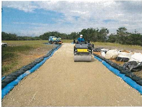
仮設道路における砂利敷設
