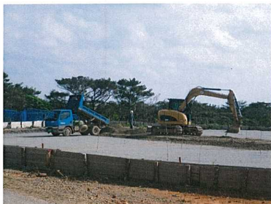
舗装工の実施状況(平成 25 年 1 月 11 日)
