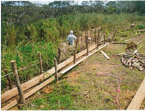
赤土等流失防止柵の杭としての再利用
