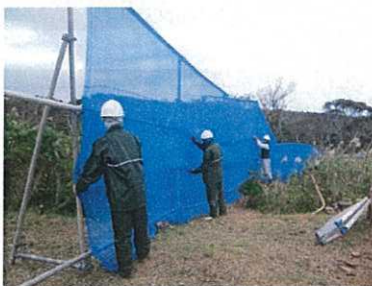
防風柵の設置
