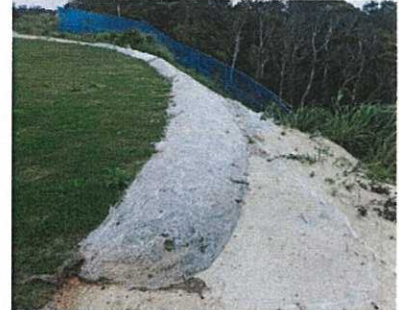
崩落地上部の小堤
