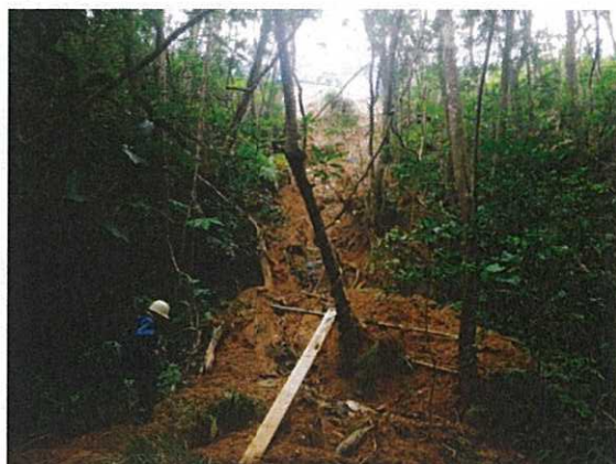
崩落直後の状況(平成25年1月12日)
