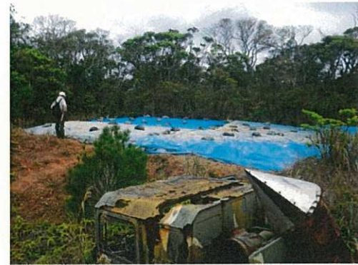
シート被覆 (N-4.1 北西側の土砂置場)
