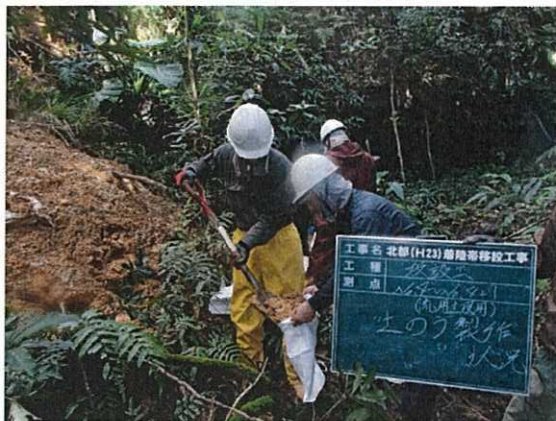
崩落した土砂を利用した土嚢製作
