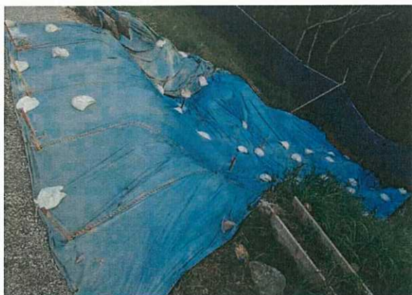
シートによる被覆(平成 25 年 1 月)
