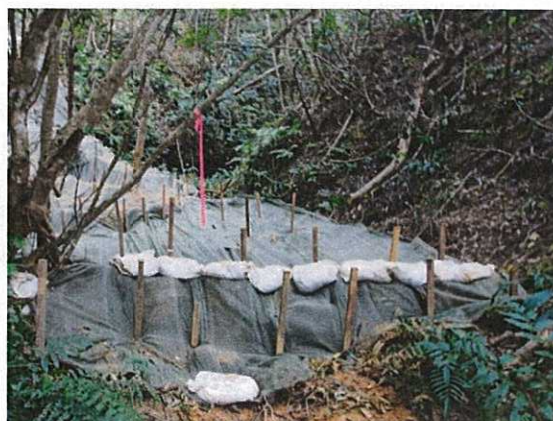
小堤の設置状況(平成25年2月7日)
