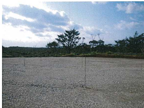
着陸帯中央付近から南側の状況(平成 25 年 1 月 11 日)
