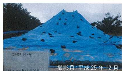
工事中の状況(降雨時)
