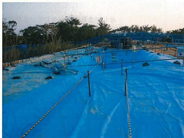
赤土対策工(沈砂池)。左:築造状況、右:設置後
