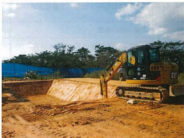
赤土対策工(沈砂池)。左:築造状況、右:設置後
