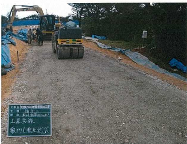
舗装工。左:転圧状況、右:表層の芝生保護材及び植栽土の敷設状況
