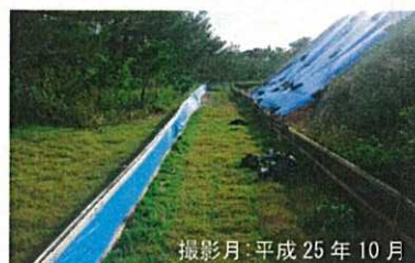
赤土流出防止柵の設置状況(N-4.2 西側)
