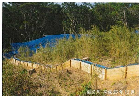
赤土流出防止柵の設置状況(N-4.2 西側)
