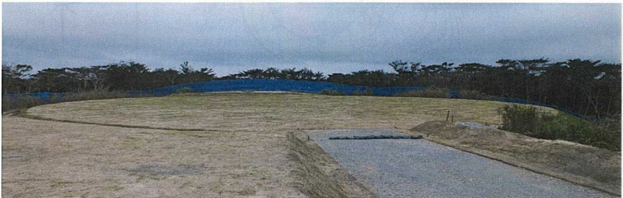
施工区域 (N-4. 2) の状況:平成 26 年 3 月
