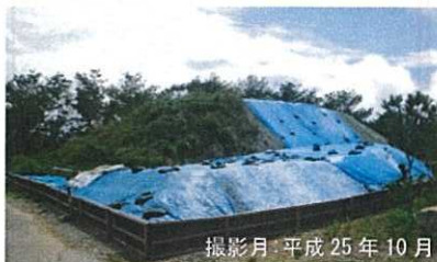
赤土流出防止柵の設置状況(土砂置場)
