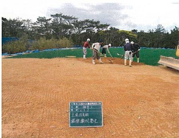
舗装工。左:転圧状況、右:表層の芝生保護材及び植栽土の敷設状況
