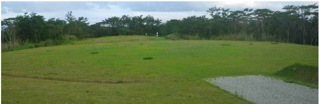
図 4.1-3 完成した N-4.2 着陸帯の状況:平成 27 年 6 月
