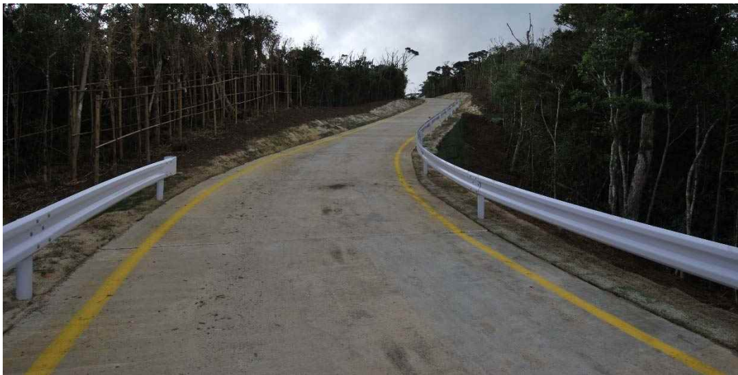
図 4.1-13 完成した G 進入路の状況：平成 29 年 10 月
