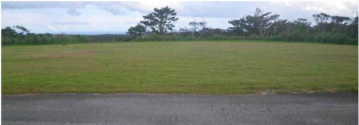
図 4.1-2 完成した N-4.1 着陸帯の状況:平成 27 年 6 月
