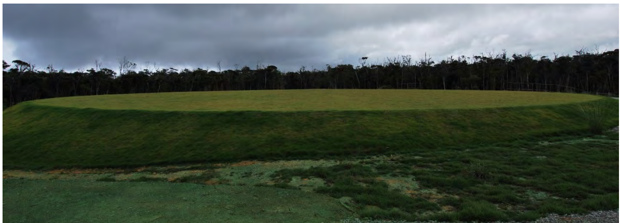
図 4.1-5 完成したG着陸帯の状況:平成 29 年 10 月
