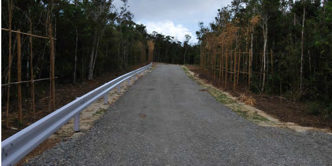
図 4.1-12 完成した G 進入路の状況：平成 29 年 10 月
