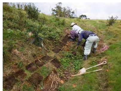
復旧作業の状況
