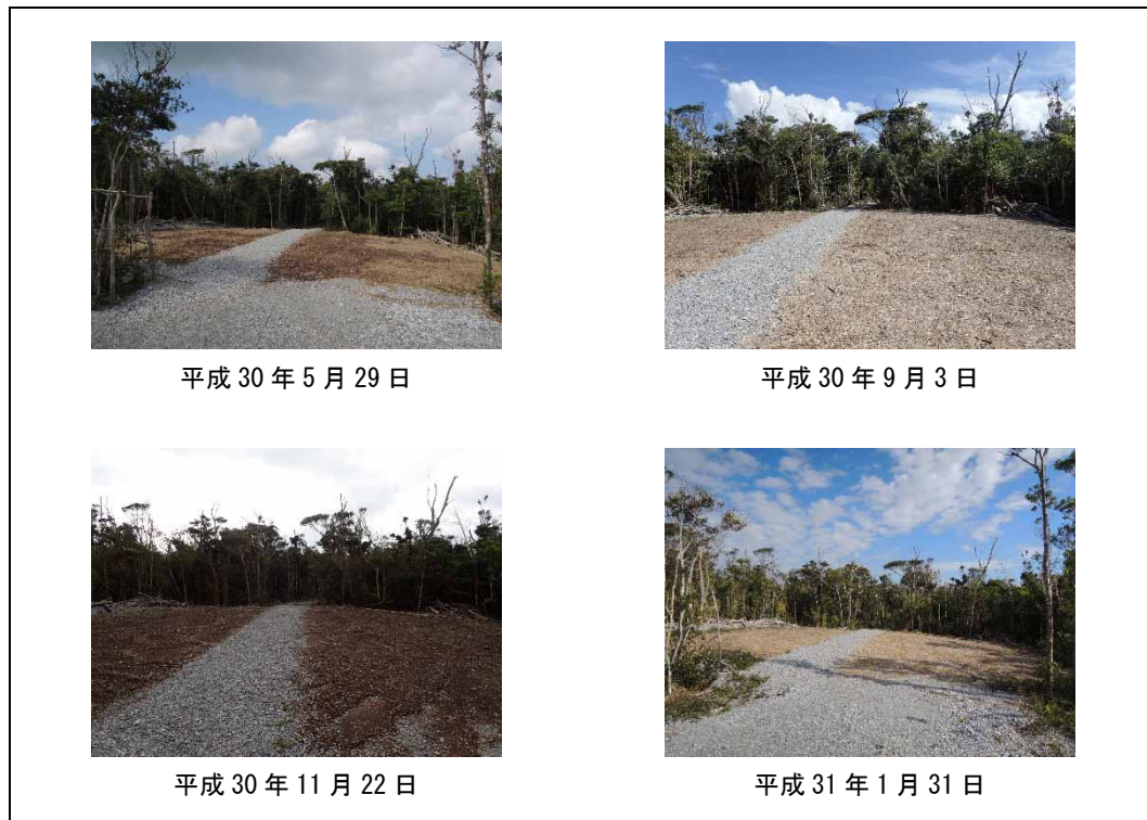
図 6.1.3-82 工事による副次的影響の復元箇所の状況(G 直近の作業ヤード)
