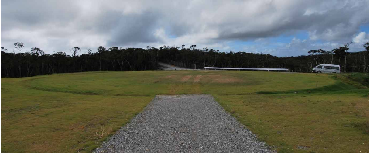
図 4.1-9 完成したN-1(a)着陸帯の状況：平成 29 年 10 月
