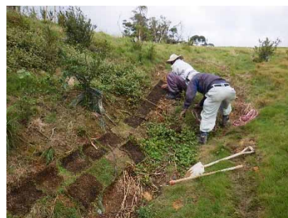
復旧作業の状況
