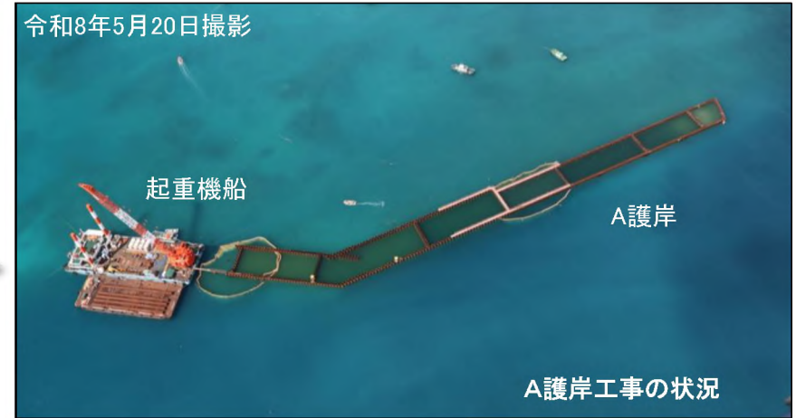
起重機船による施工状況(イメージ)
