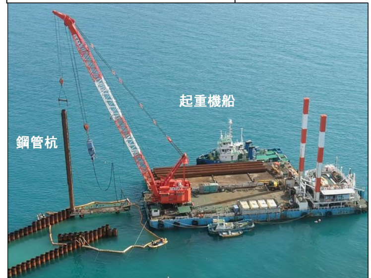
起重機船による施工状況(イメージ)
