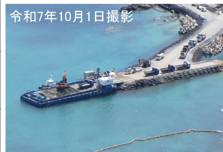
[参考] 護岸を用いた揚土の状況(K-9護岸)
