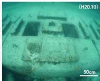
凹凸加工根固ブロックの設置状況
