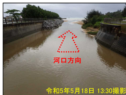
令和5年5月18日 13:30撮影 辺野古川の状況(ナメラー橋から下流向け)
