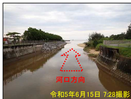
辺野古川の状況(ナメラー橋から下流向け)
