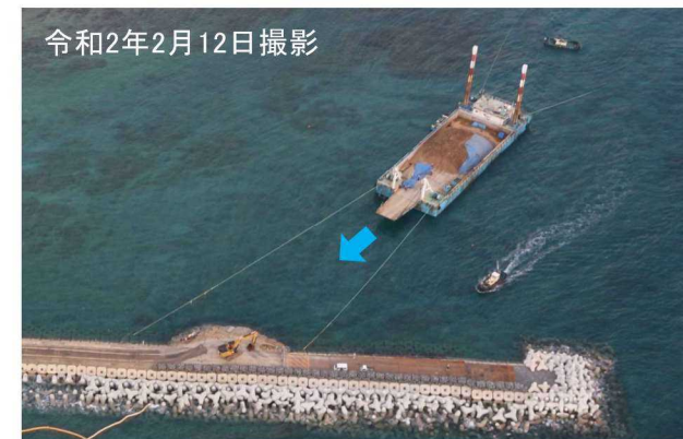
[参考] K-8護岸を用いた揚土の状況
