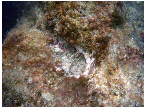
②付着生物を除去した状況
