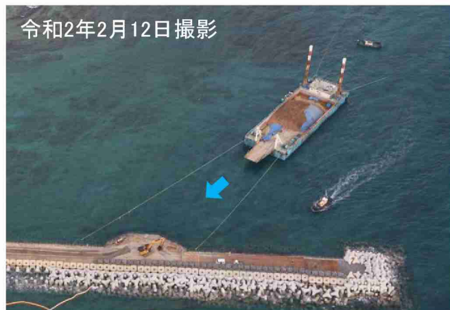
[参考] K-8護岸を用いた揚土の状況
