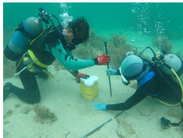
設置作業状況
