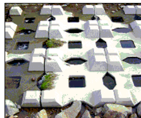
護床ブロックへの砂礫による空隙充填の実施イメージ例
