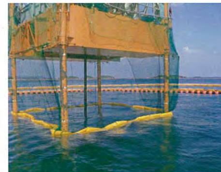
【オイルフェンスの設置状況】
