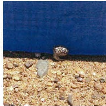
写真2.5.1 オカヤドカリ類等の進入防止柵の設置状況
