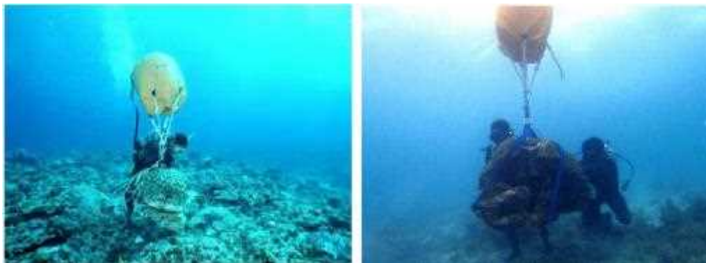
図7 エアリフターでの運搬イメージ
