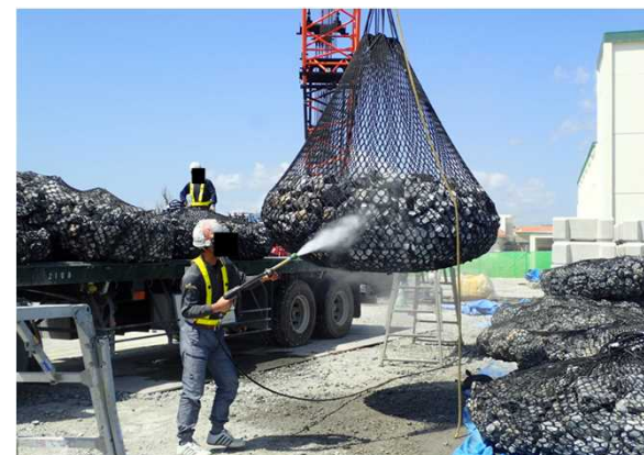
○作業員による高圧洗浄機を用いた洗浄
