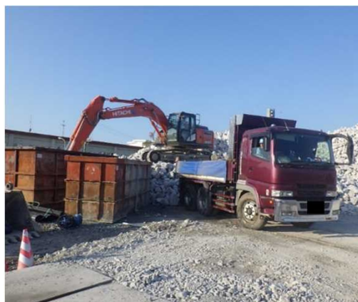
○ダンプトラックに積み込み
