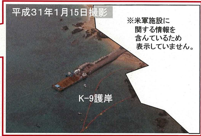
埋立材の搬入作業
