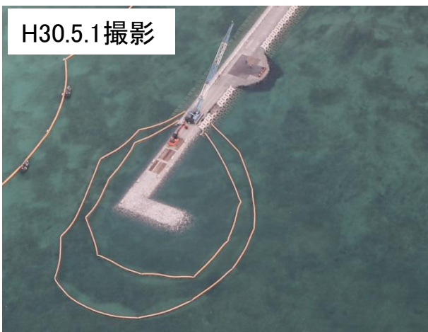
汚濁防止柵設置による施工状況
