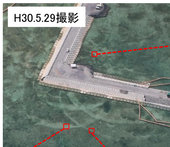
海草藻場の損傷の状況
