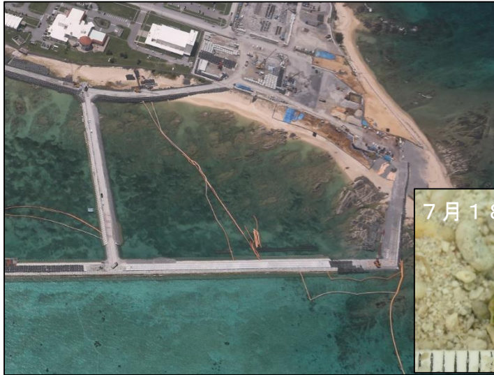
K-4護岸の概成の状況(平成30年7月23日撮影)
