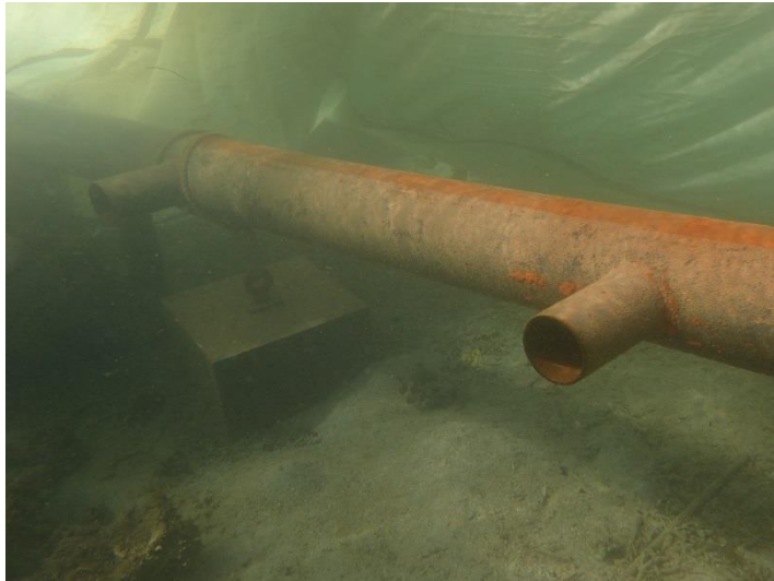
配管(吐出口)の状況
