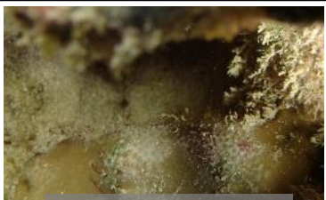
部分的に白化を確認
