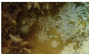
部分的に白化を確認
