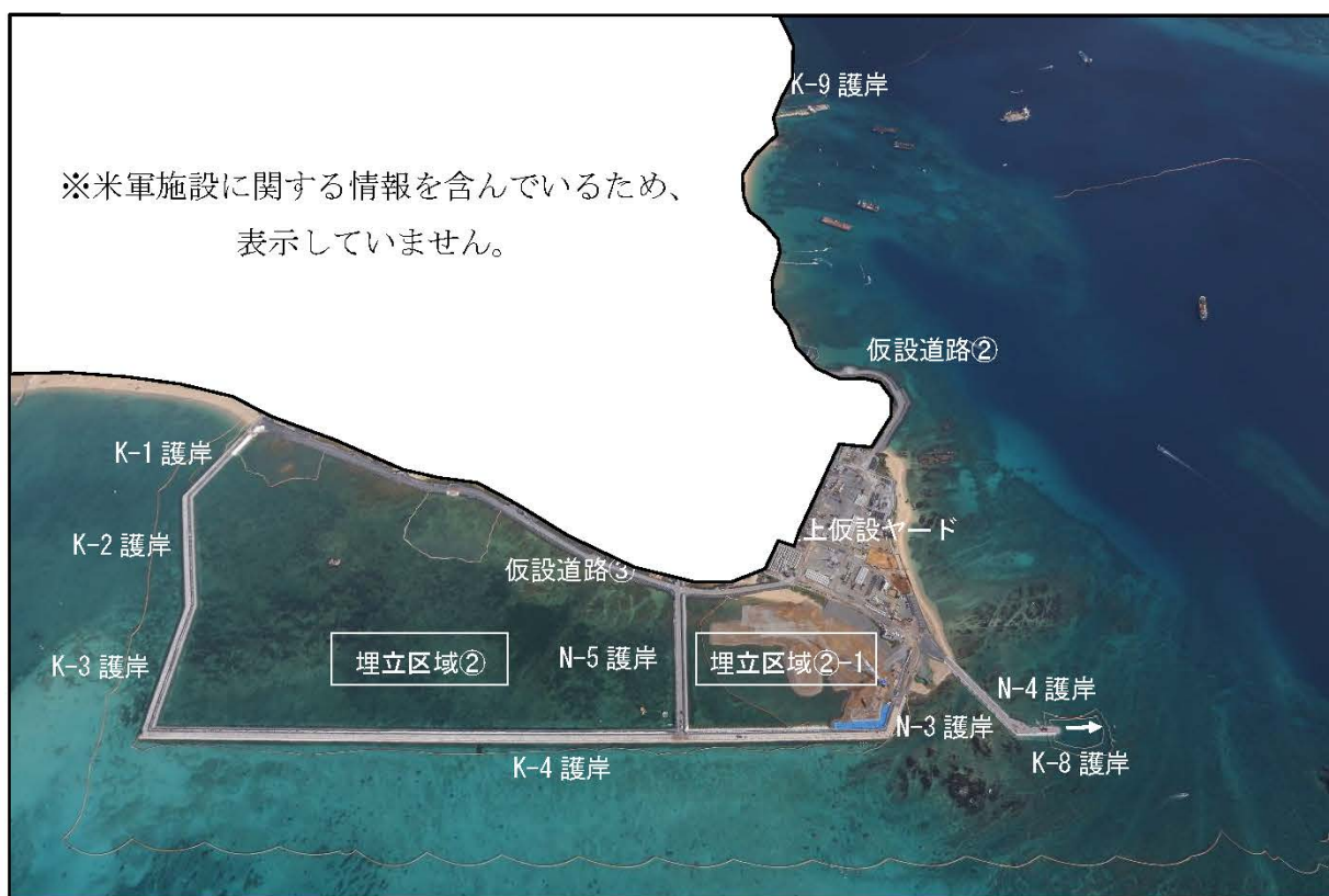
工事の実施状況（平成 31 年 3 月末時点）
