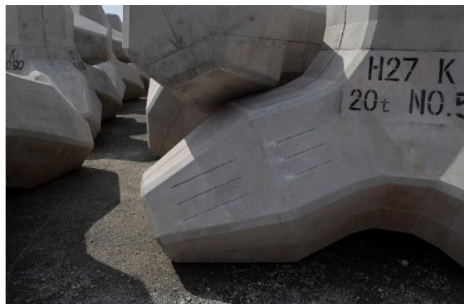
(海藻類の生育基盤の改善：消波ブロックの加工)
