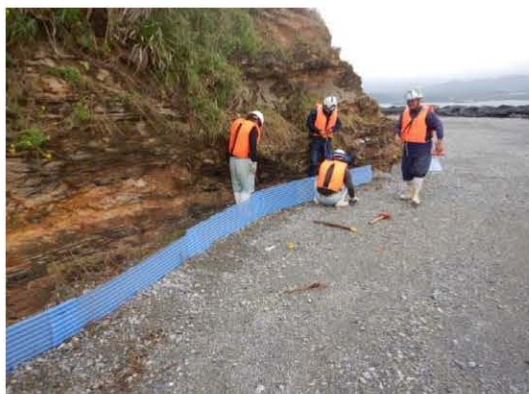
(改変区域の境界における進入防止柵・パイプの設置)
