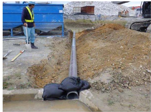
(仮設排水路・排水管の設置)
