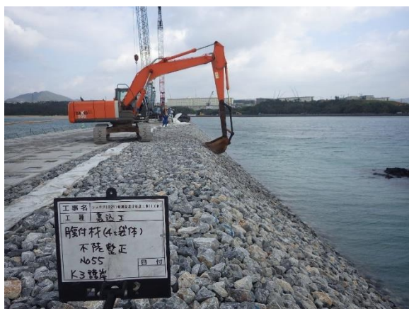
(傾斜堤護岸 K-3)
