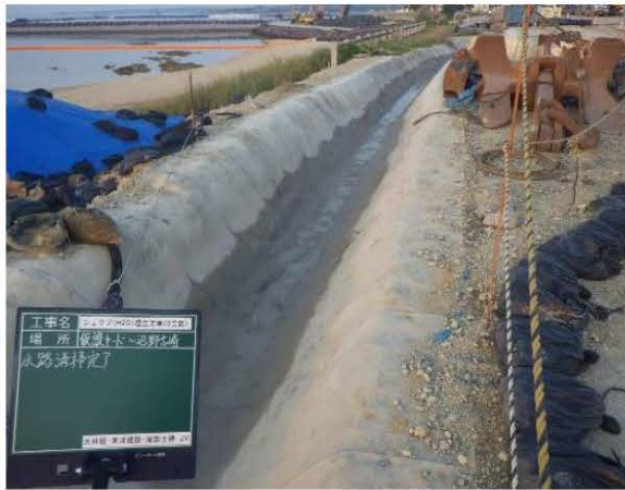
(仮設排水路・排水管の設置)
