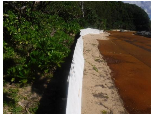
進入防止柵の周辺状況
