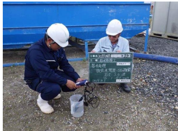
(濁水処理プラントの設置、放流水濁度確認)
