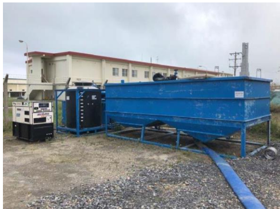
(濁水処理プラントの設置、放流水濁度確認)
