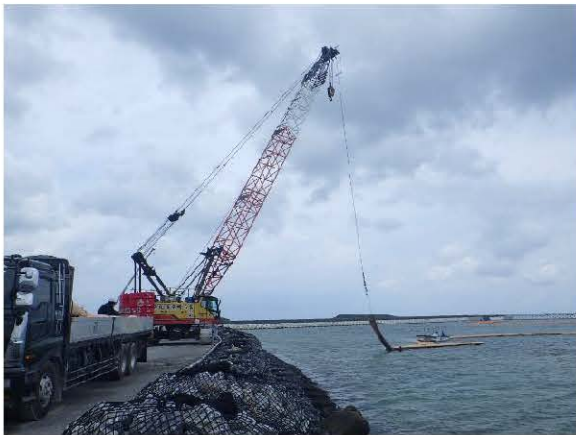
(汚濁防止枠の設置・使用)
