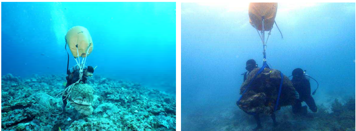
図-3.3.11 エアリフターを用いた人力運搬のイメージ
